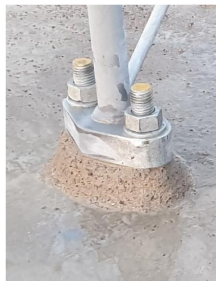
Exempel på undergjutning
