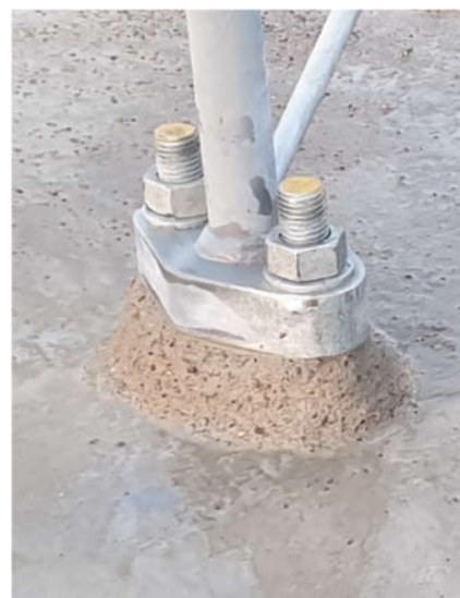
Exempel på undergjutning
